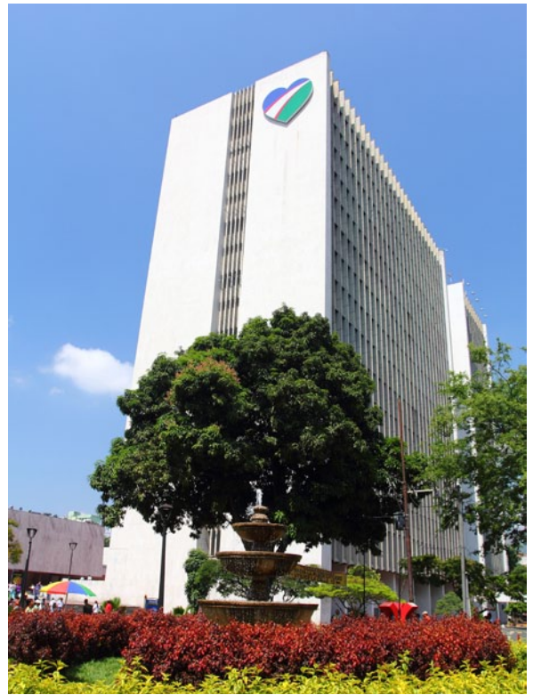
Edificio de las Empresas Municipales de Cali, Valle del Cauca. (EMCALI).
